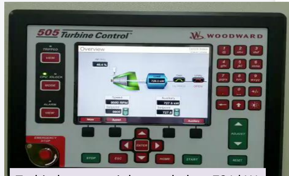
Turbin beroperasi dengan beban 731 kW
